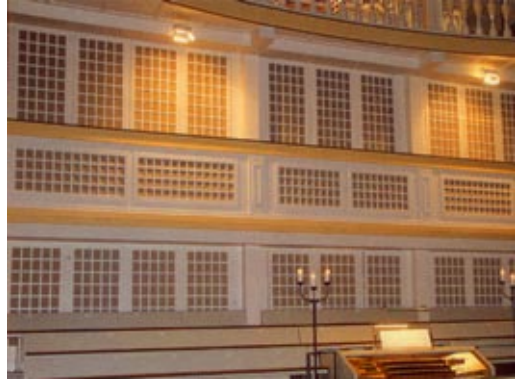
Architektonische Vorderfront vor der Steinmeyer-Organ in der Bachkirche (Arnstadt), klangdurchlässige Gitter mit Stoffbespannung
